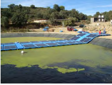
ISIFLOATING. Sistema flotante para aplicaciones fotovoltaicas. ISIGENERE.
